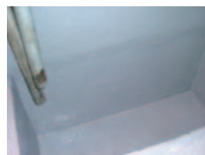
地下ピットライニング処理
