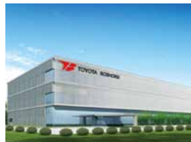
豊田紡織(中国) 本社・R&Dセンター新社屋を建設中
