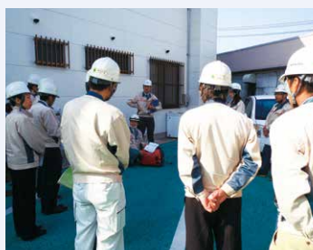
模擬訓練で発電機の試運転
