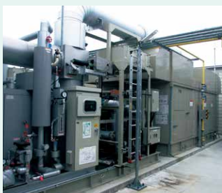
岐阜工場のコージェネレーションシステム
