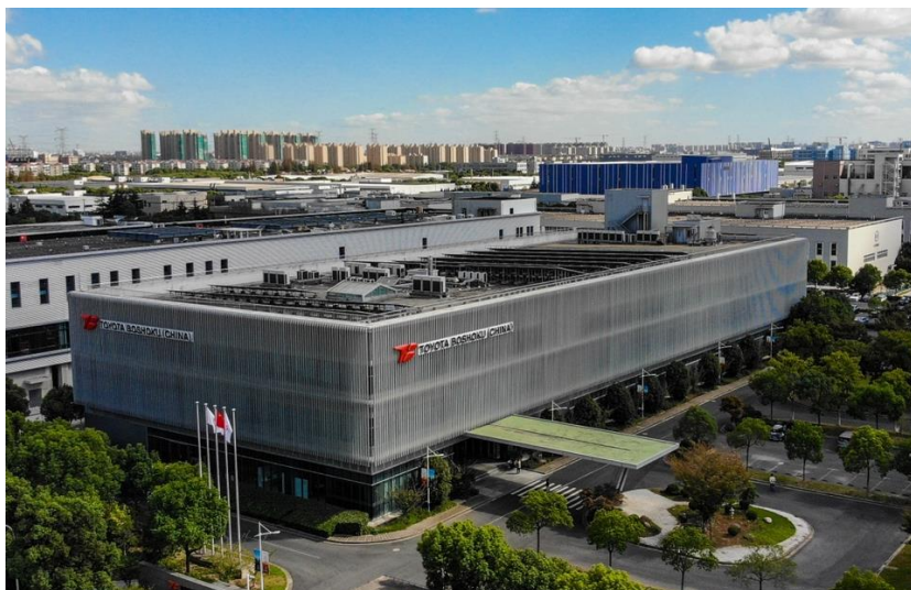
丰田纺织中国地区总部大楼
