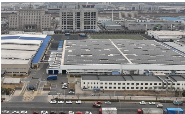
天津工厂屋顶分布式光伏发电
