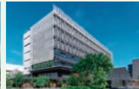
「グローバル本社新本館」
