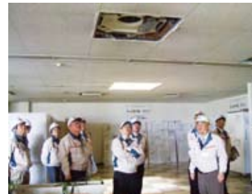
トヨタ紡織東北の被災状況を視察する豊田社長
