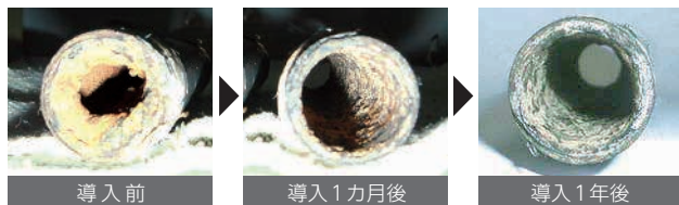
金型冷却水配管内の水垢除去
